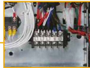
Dış ünite güç besleme terminal bloğu
